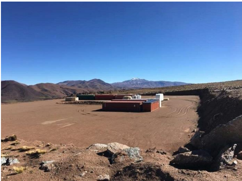
El sitio de LLAMA con los componentes de la antena desmontados.
